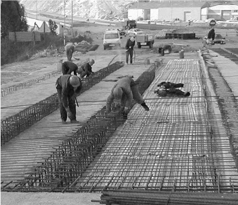
Fig. 2. Vista del ferrallado
